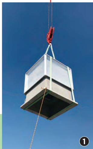
◀クレーンで 屋上に揚重する。
